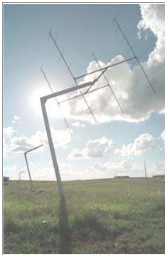
Figura 3.18 – Estrutura coletora parcialmente montada no Observatório Espacial do Sul – OES/CRSPE/INPE – MCT.
